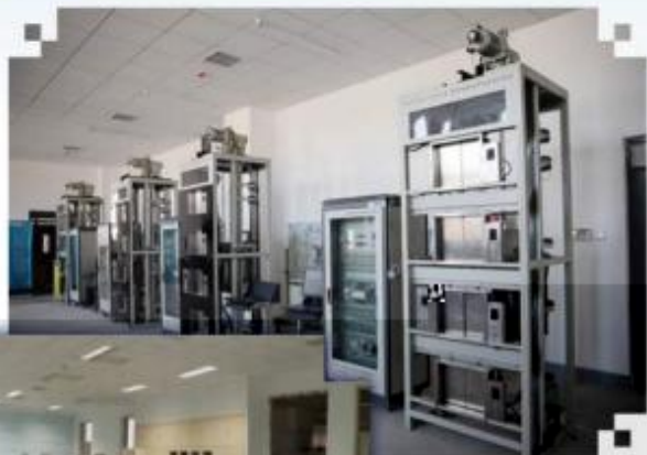
智能电梯安装调试 维护训练场所
